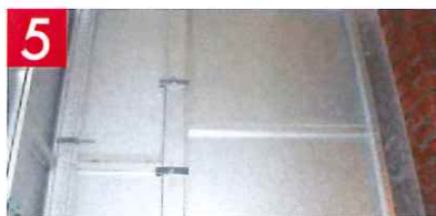
5 パネルの隣り合わせ部分にカバーを被せて専用金具で固定します。
