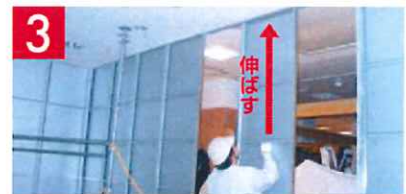
3 パネルを下部ランナーに立てかけて上部ランナーに飲み込むまで伸ばします。
