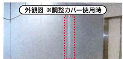
6 調整カバー部分は外から見て凹んだ状態になります。
