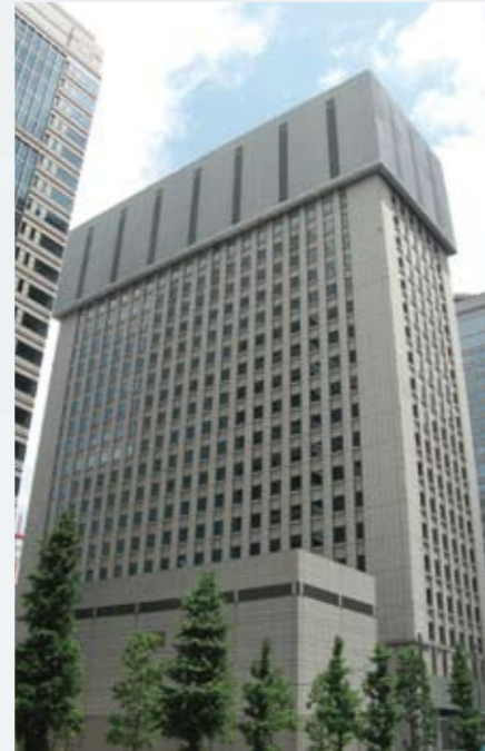
超高層ビル(100M超)解体工事(大手町)
