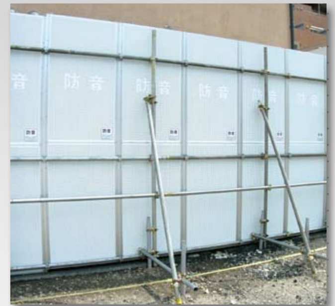
裏面 吸音構造 デザインパンチングで防音文字を表現しました。
