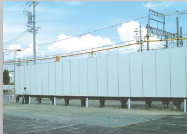
鉄道沿線工事物件 周辺住民 防音対策と美観性・強度(H:3000mm仕様)
