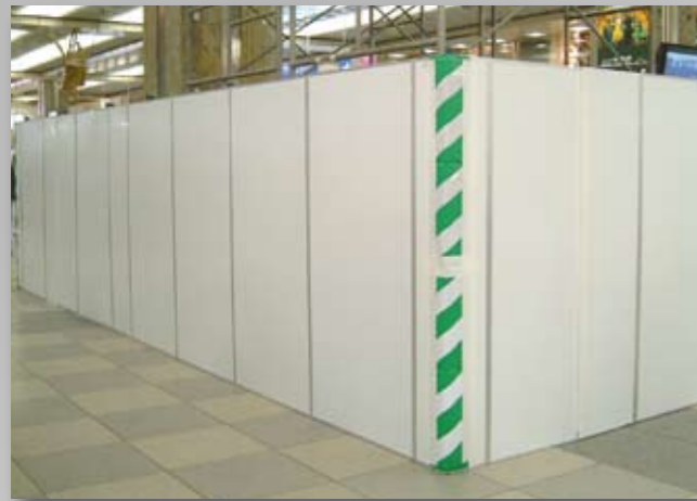
駅舎構内工事物件 利用客 防音対策と軽量・美観性(H:2000mm仕様)
