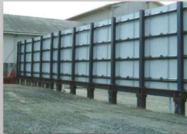
鉄道沿線工事物件 周辺住民 防音対策と美観性・強度(H:3000mm仕様)
