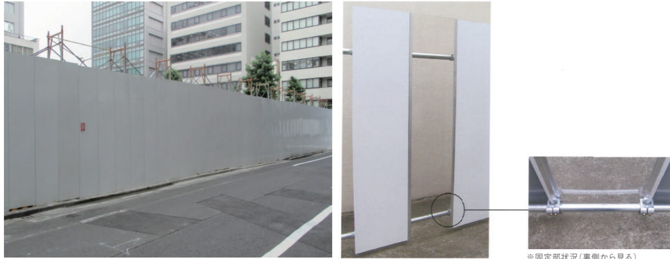
※固定部状況(裏側から見る)
